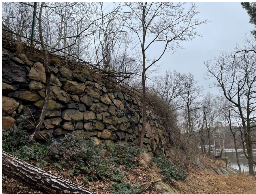
Figur 8. Del av stödmur. Förskoleverksamhet planeras på den plana yta som skapas av muren. Foto: Nacka kommun.
