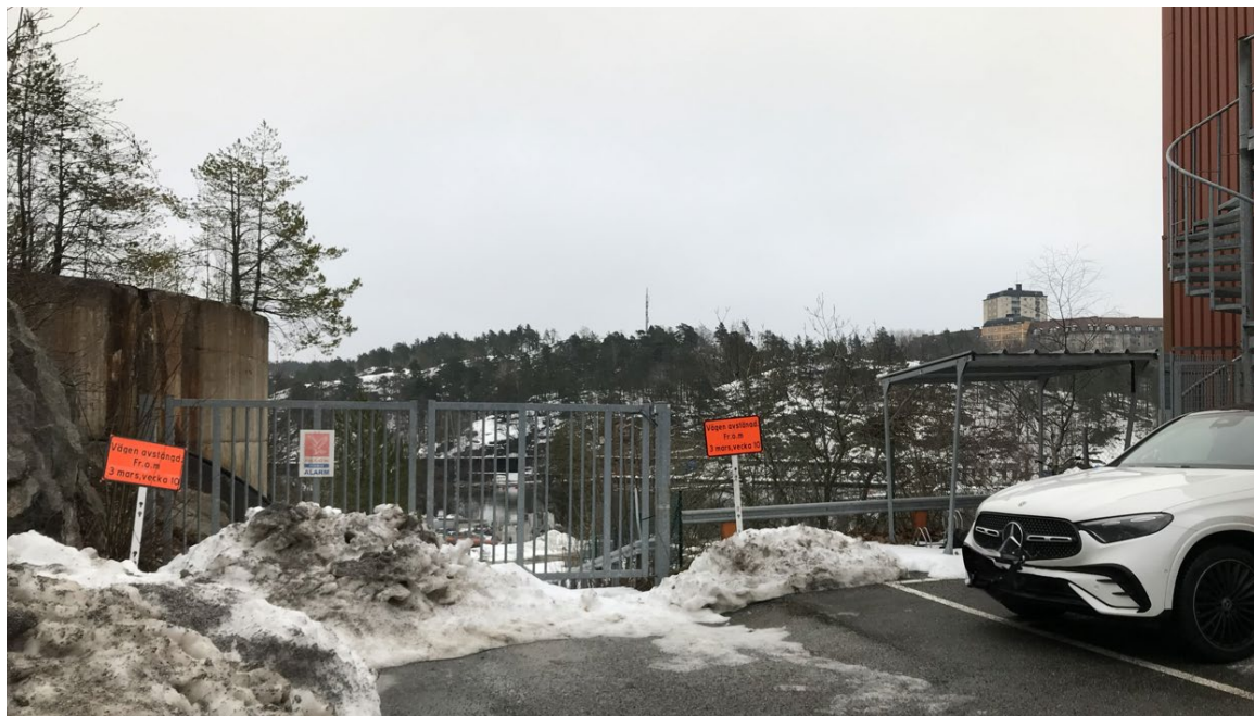
Figur 6. Stängsel och grind mellan den norra delen av Scenhuset och branten längs Kvarnholmsvägen. Foto: Nacka kommun.
